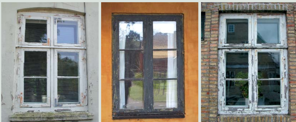
Vinduer fra h.h.v 1860, 1820 og 1780 svarende til de nedennævnte 3 tilstands- og istandsættelsesgrader/niveauer: 1: Almindelig vedligeholdelse, 2: Nænsom istandsættelse og 3: Total istandsættelse. Vinduer til total udskiftning støder man meget sjældent på, undtagen vinduer yngre end 1960-70.
