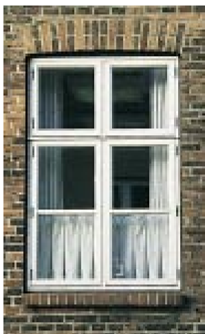
Fire-rammet klassicistisk vindue i Algade.
